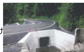
排水工の設置
