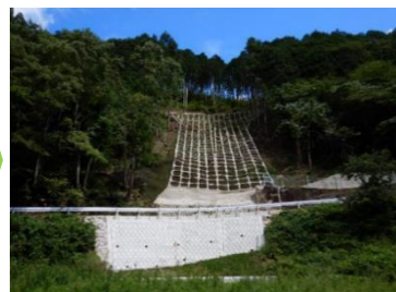
豪雨により崩壊した山腹の復旧
